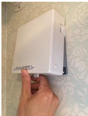
④次にカバーを外します。 下部の突起を手前に引くと外れます。
