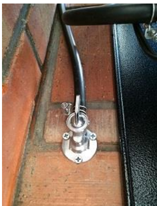
開いている状態:レバーが送油管と並行
